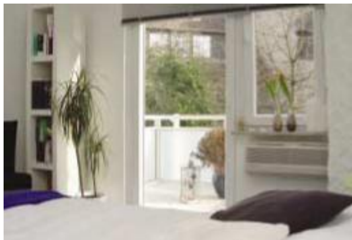
Bild 9: Inverter-Wärmepumpe in einem Schlafzimmer
