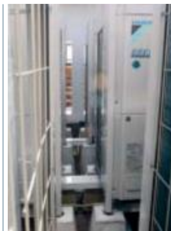
Bild 4: Fertigtbetonsockel für Außengeräte
